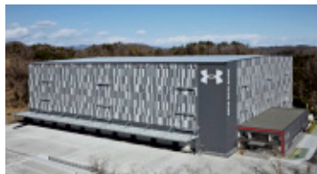
免震大型物流施設
